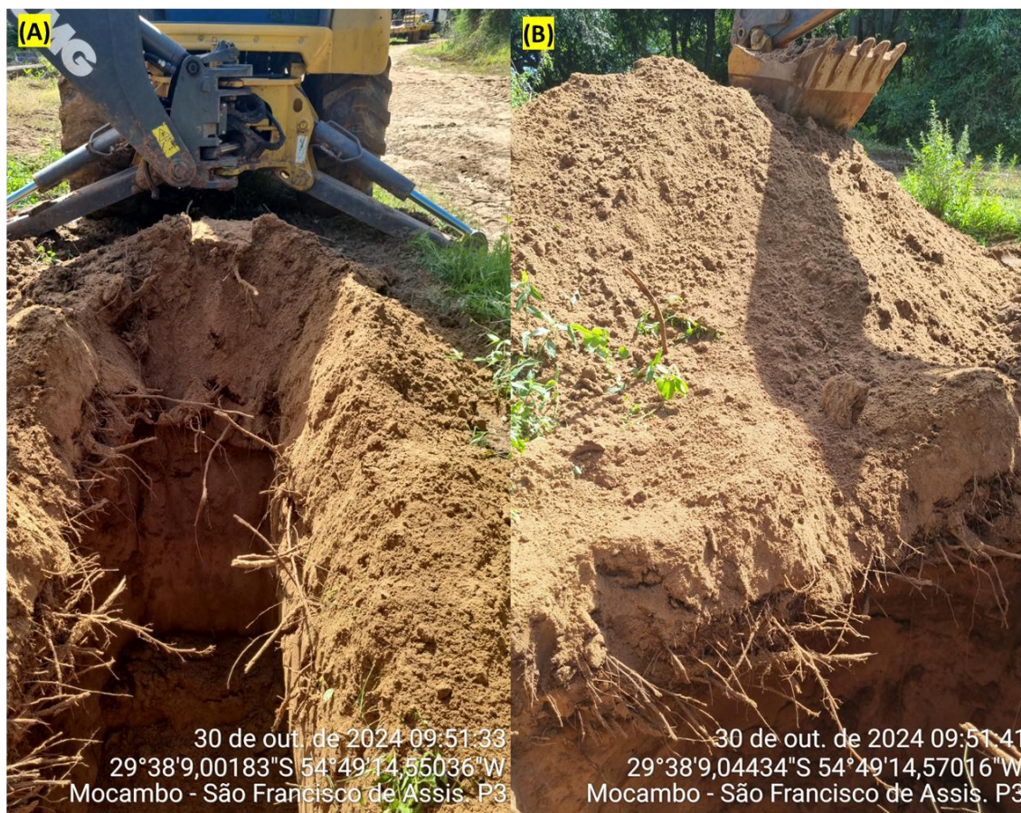
Figura 8 – Abertura do poço de inspeção 02.
