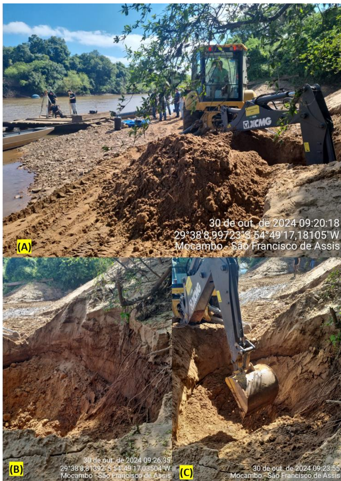
Figura 4 – Poço de inspeção 01, em cota próxima a cota de implantação das fundações da futura ponte.
